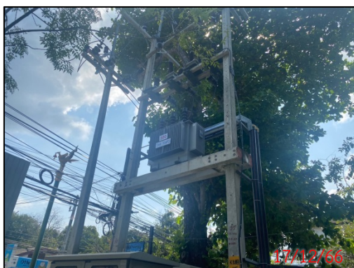
รูปที่ 2.2-5 หม้อแปลงภายในโครงการ
